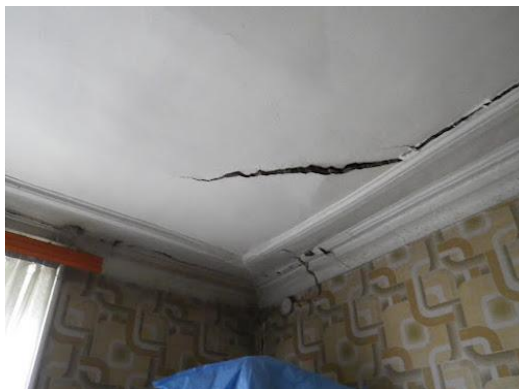
loskomende bepleistering
