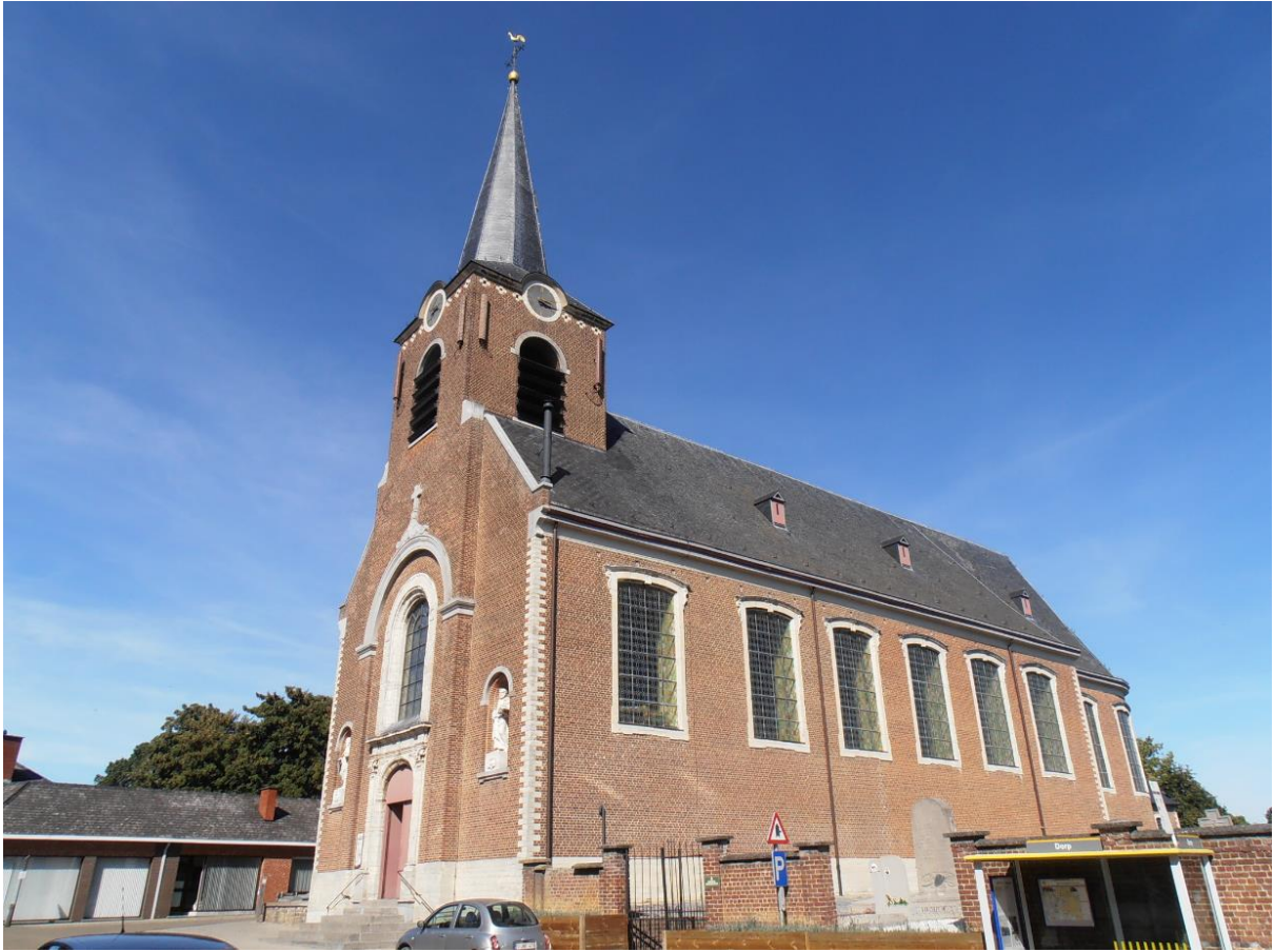
Afb. 2: Zicht op de hoofdingang en de westelijke zijgevel van de kerk met omliggend kerkhof.
