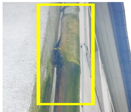
opengescheurde afvoerbuis
