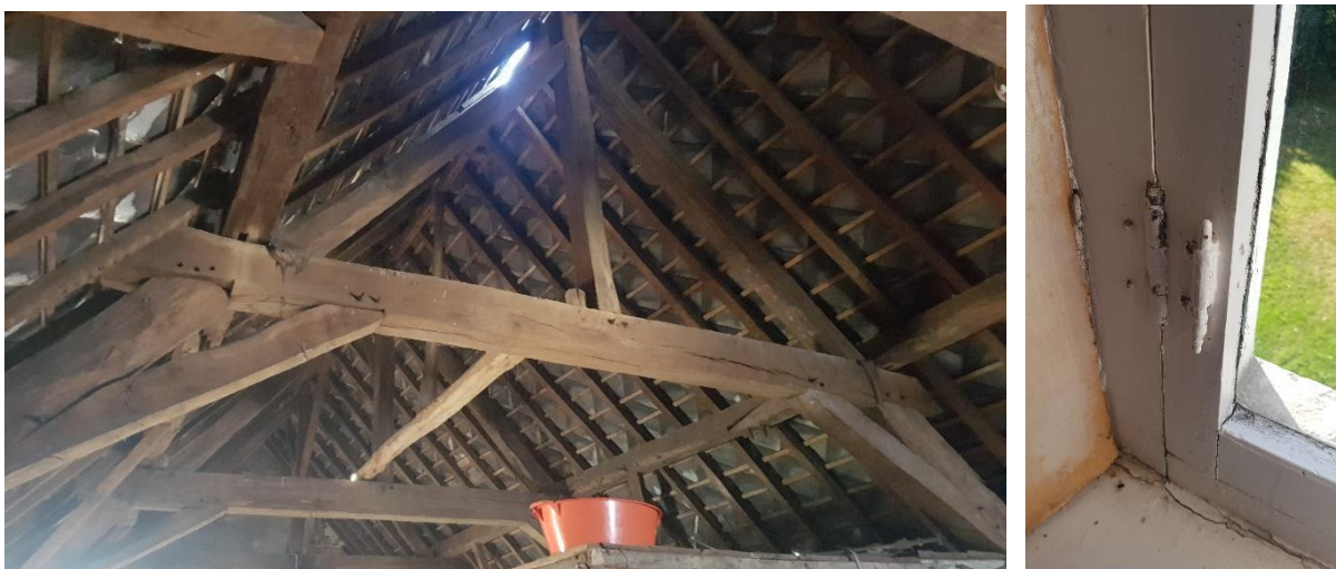
Fig. 2: Zicht op de bovenzijden van de spanten (links) en detail van het dakkapelraam (rechts).
