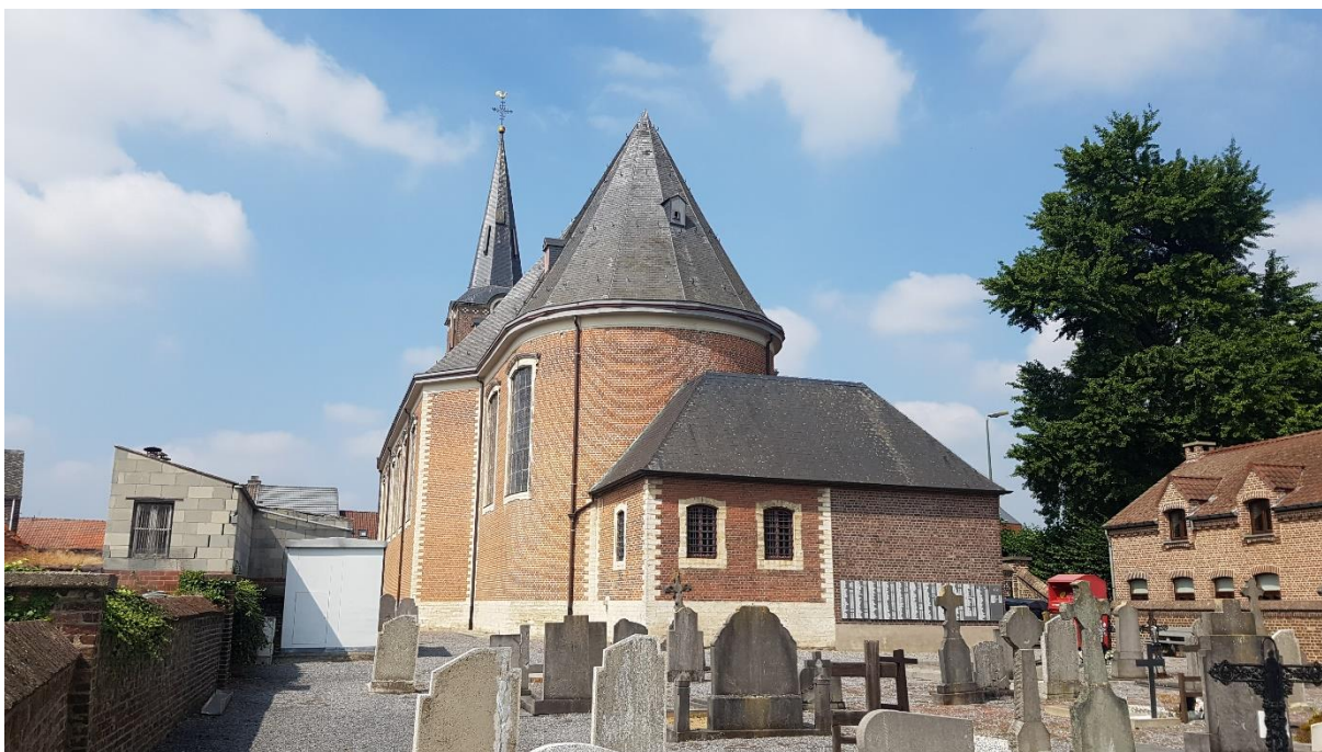
Afb. 70: Overzicht van de oostgevel
