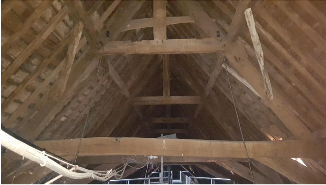
Afb. 104: Zicht op de houten kapconstructie van de zolder.
