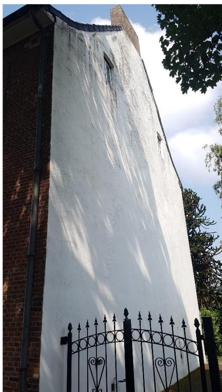
Afb. 128: Zicht op de oostgevel.
