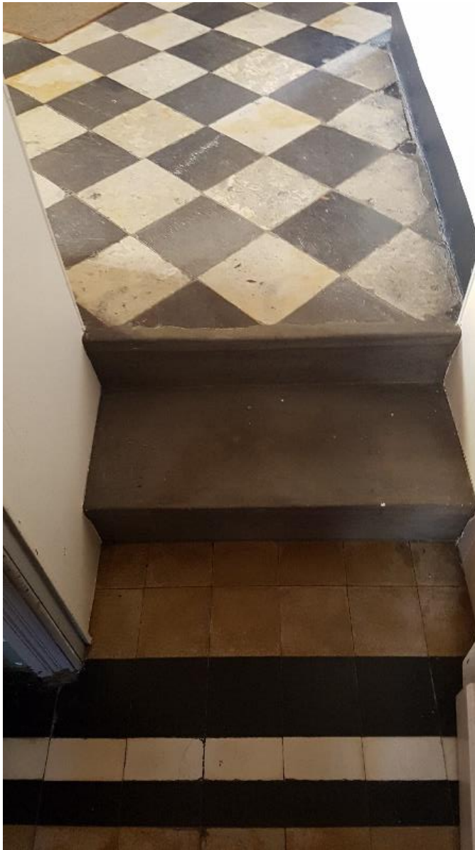
Afb. 102: Overgang van de sacristievloer naar de bergingvloer.
