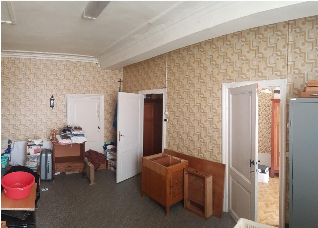
Afb. 151: Overzicht van ruimte 1.4.
