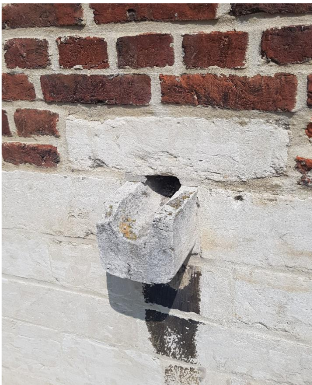
Afb. 73: Afloop in de zuidgevel (links) en dichtgemetseld venster in de zuidgevel (rechts).
