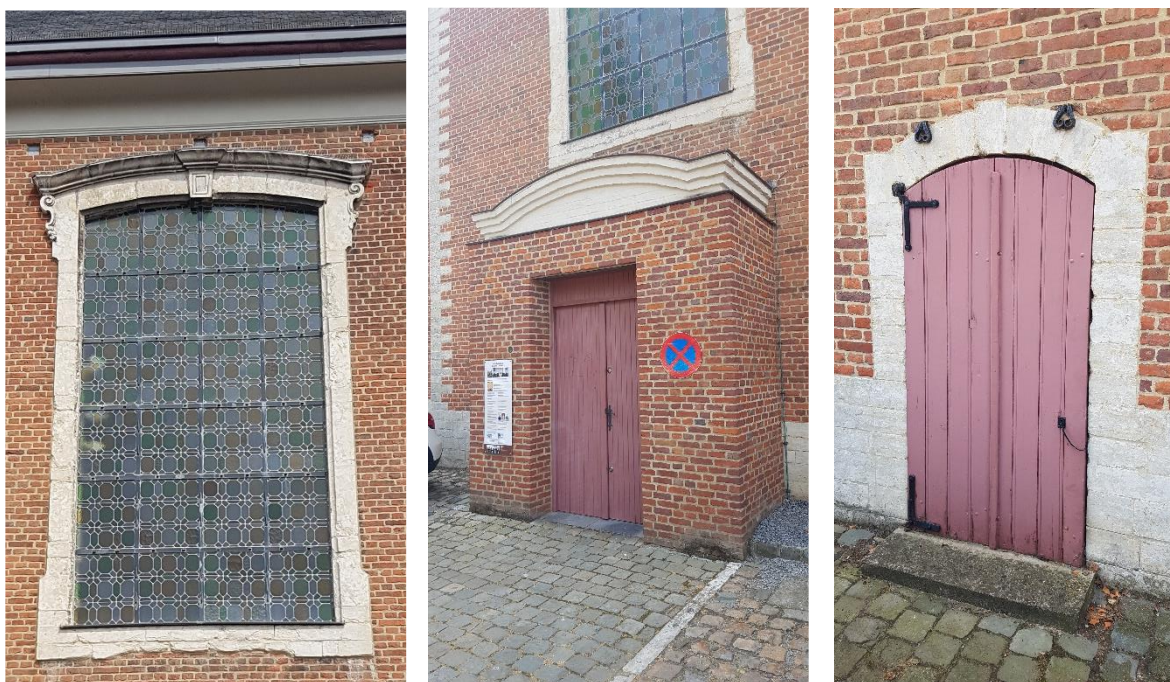
Afb. 71: Detail van de vensteromlijsting, stellinggaten en keellijst (links), art-deco-inkomportaal (midden) en poortje in koormuur (rechts).
