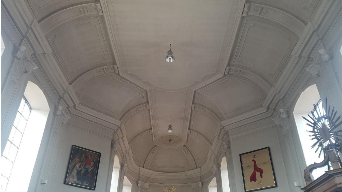
Afb. 86: Overzicht van het stucplafond.
