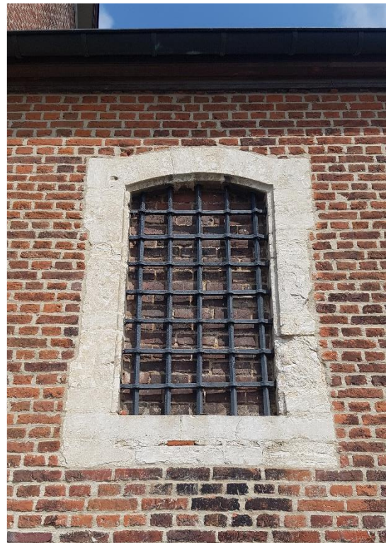
Afb. 73: Afloop in de zuidgevel (links) en dichtgemetseld venster in de zuidgevel (rechts).
