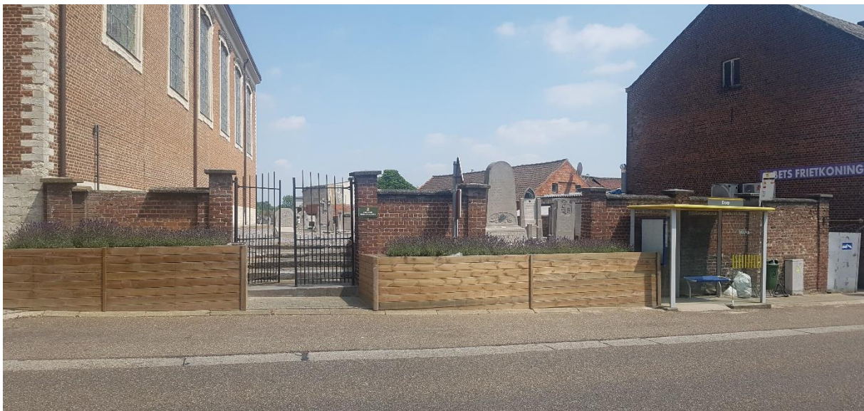
Afb. 117: Zicht op de buitenzijde van de westmuur met bloembakken (zonder erfgoedwaarde), inkomhek en opening voor het oorlogsmonument.
