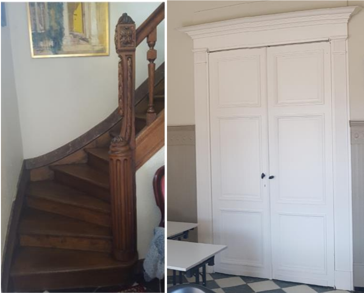
Afb. 48: Links: 18 de -eeuwse houten trap, waarvan de gecanneleerde trappaal uitgewerkt is in Louis XVI-stijl. Rechts: Vermoedelijk 18 de -eeuwse binnendeur in de huidige vergaderruimte.
