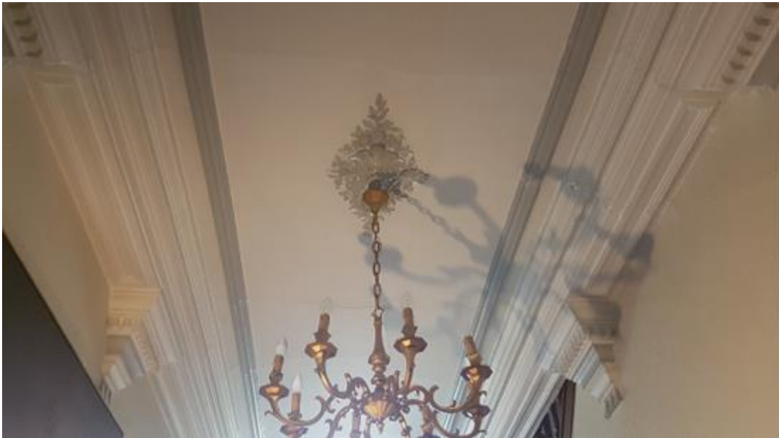
Afb. 49: De 19 de -eeuwse pleisterplafond in de inkomhal met centraal rozet heeft zwaar geprofileerde kooflijsten, welke worden ondersteund door consoles.
