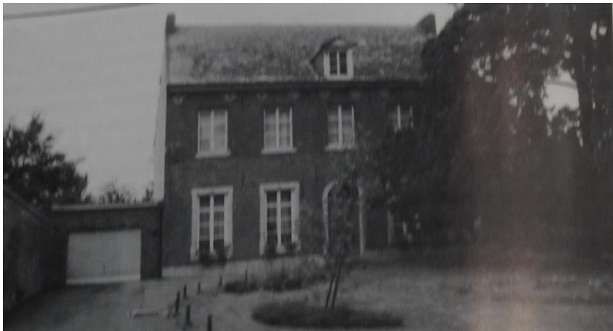
Afb. 47: Voorgevel van de pastorie van Geetbets en de garage, in 1992.
