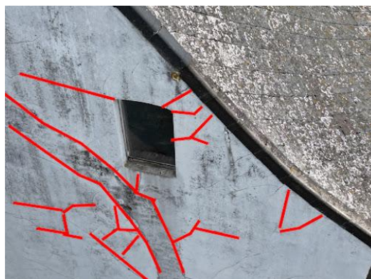
verspreid scheurvorming
