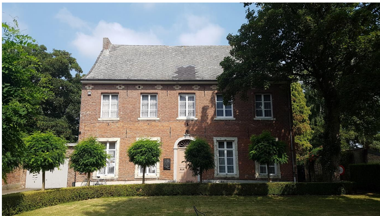
Afb. 124: Overzicht van de zuidgevel.
