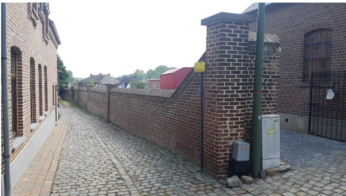
Afb. 115: Buitenzijde van de zuidelijke ommuring met recent hekwerk.
