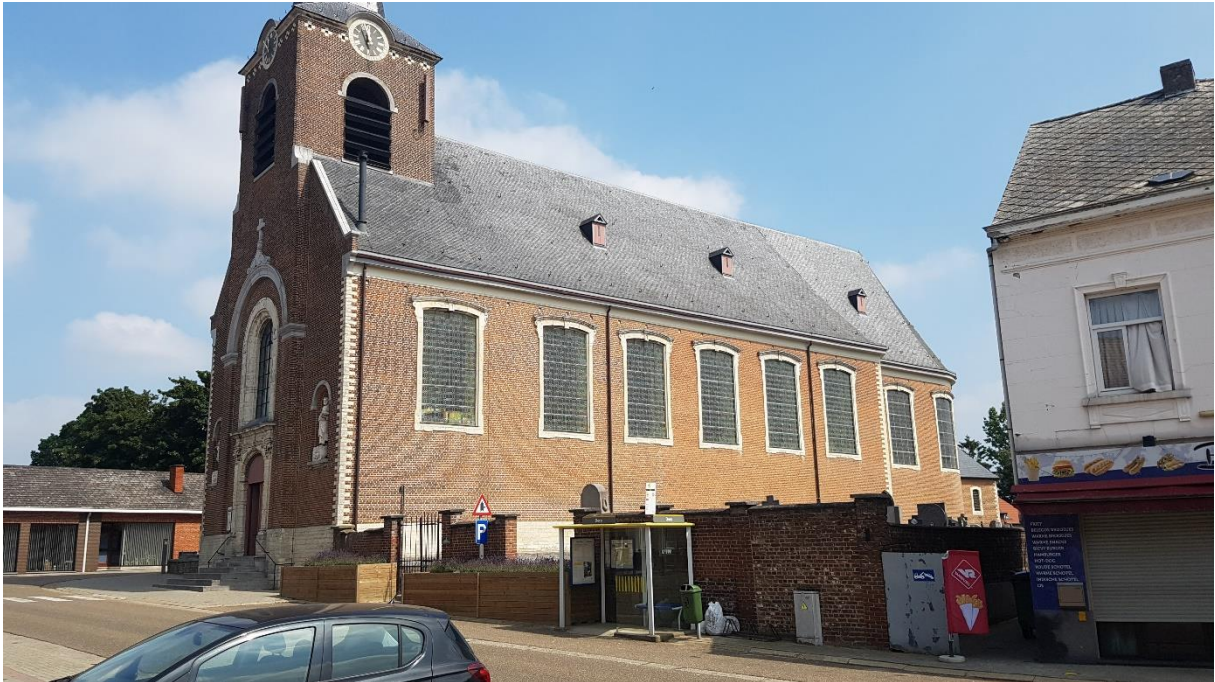
Afb. 68: Overzicht van de zuidgevel.
